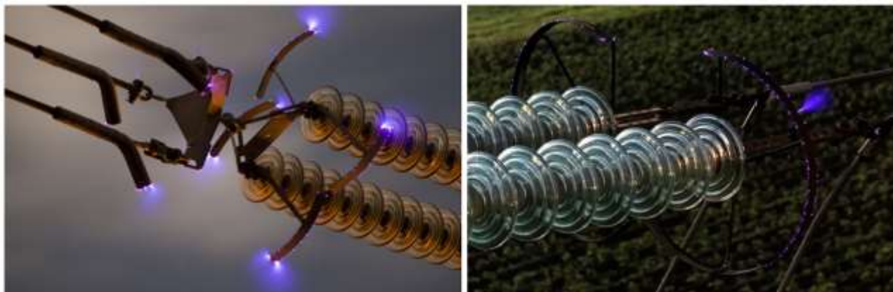
Рис. 1. Коронные разряды на защитных элементах высоковольтной воздушной линии электропередачи с напряжением более 500 кВ
